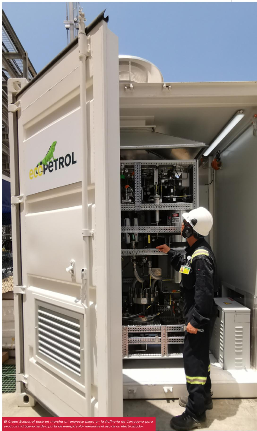
El Grupo Ecopetrol puso en marcha un proyecto piloto en la Refinería de Cartagena para producir hidrógeno verde a partir de energía solar mediante el uso de un electrolizador.
